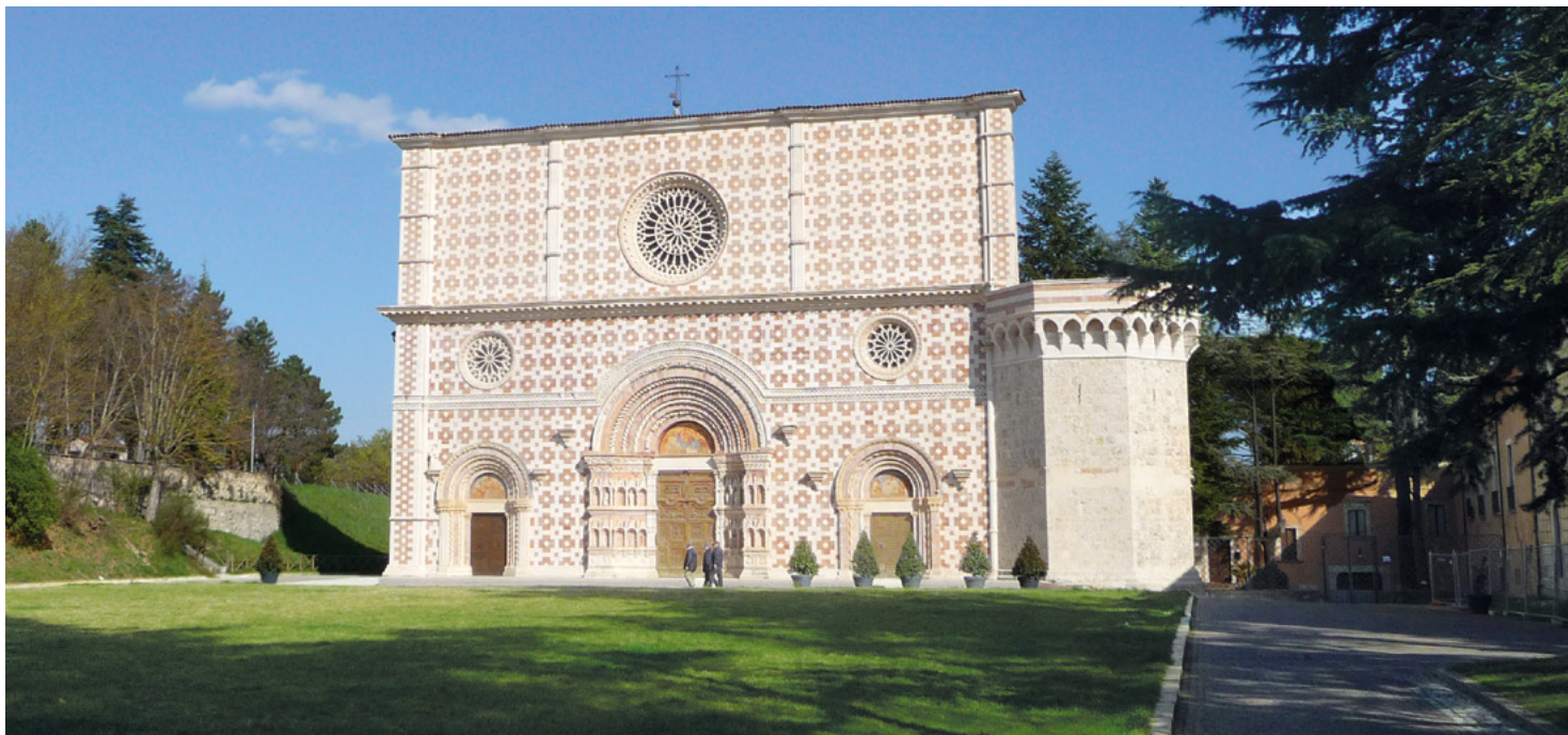
Antonella Martinelli - "Basilica di S. Maria di Collemaggio" - Collemaggio (AQ)
